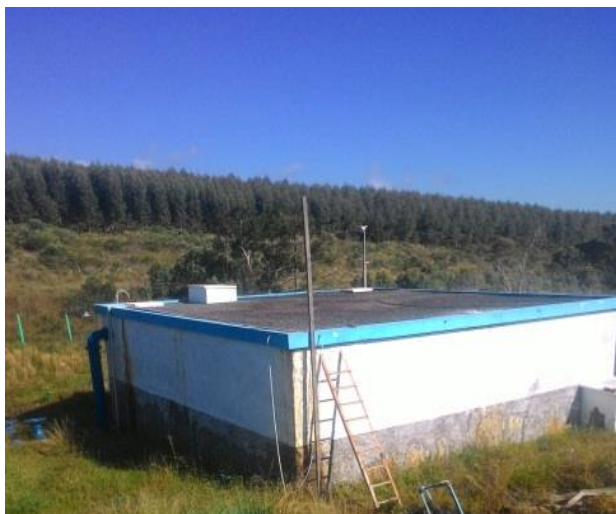
Figura 07 - Reservatório C2 - Três Bocas
