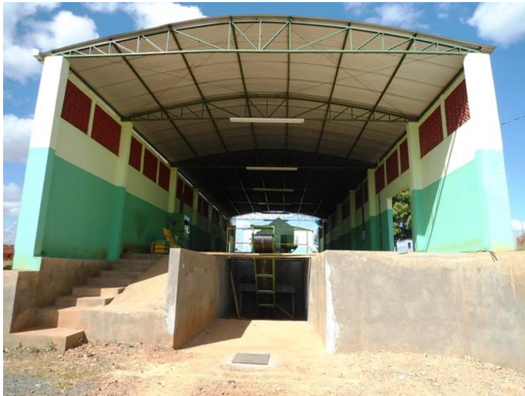
Foto 3 - Vista externa da Usina de Reciclagem - 01
