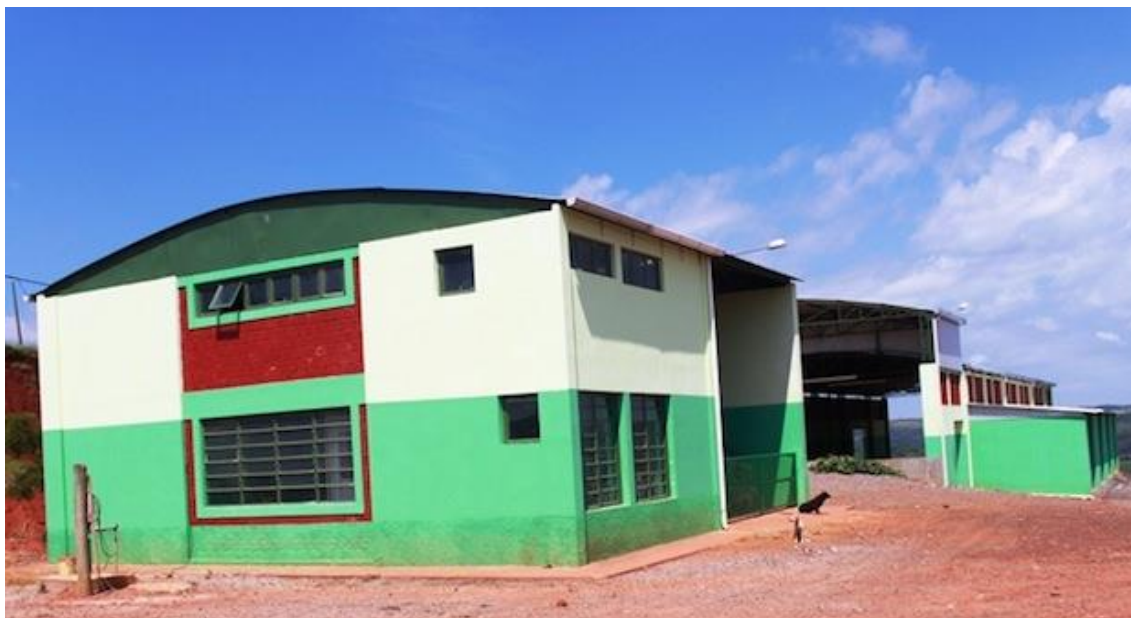
Foto 4 - Vista externa da Usina de Reciclagem – 02
