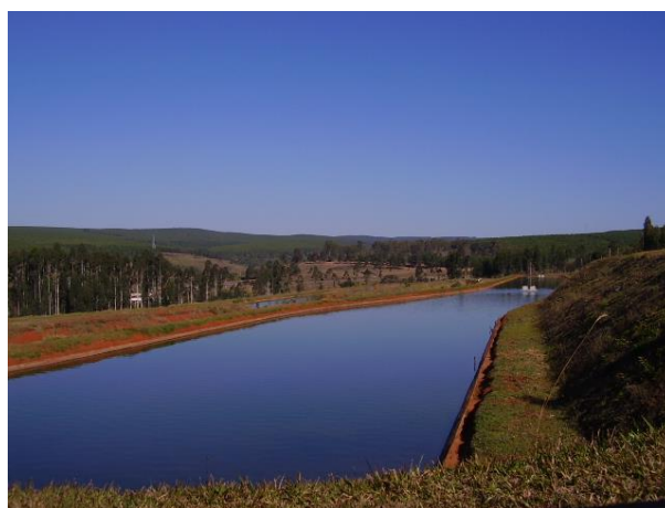
Figura 6 – Estação de Tratamento de Esgoto (ETE).
